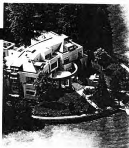
FLICK-BURG in Schiefing/Auen am Wörthersee. Viel Beton, herrlicher Ausblick.
